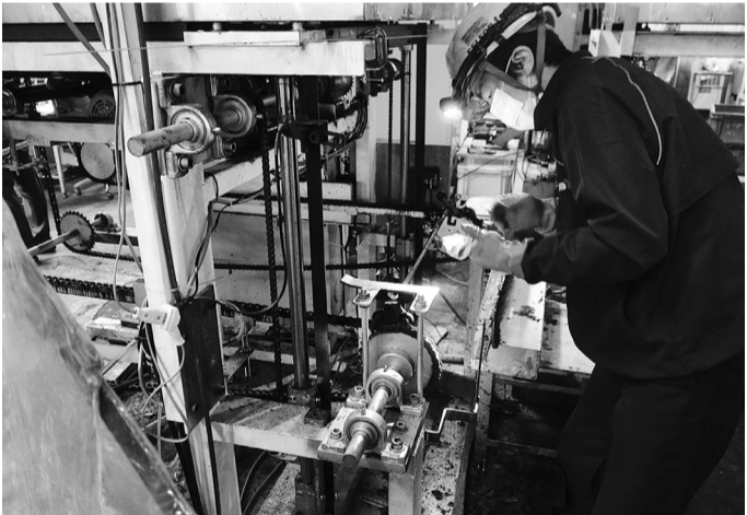
機械設備の修復
