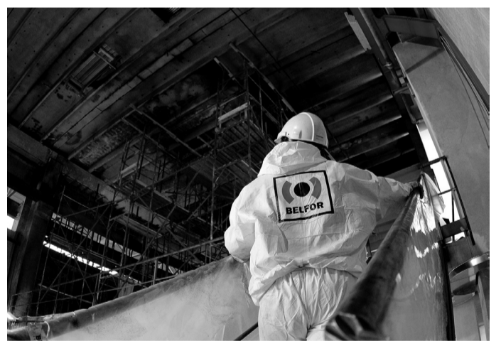
建物の汚染除去
